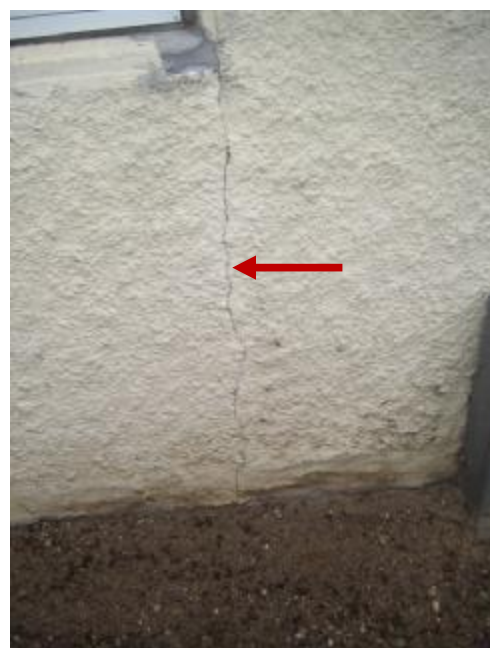
Sætningsrevne i sokkel mod Skovbrynet 2
