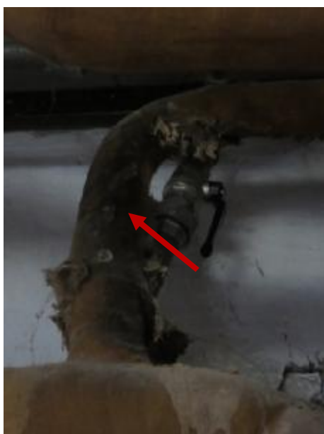
Varmeinstallation i fyrrum. Tegn på fugtskaded isolering.
