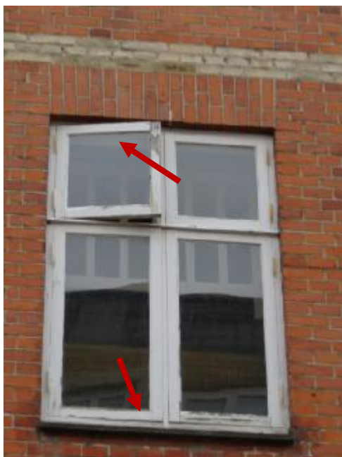
Vindue i trappeopgang med kraftig malingsafskalling.
