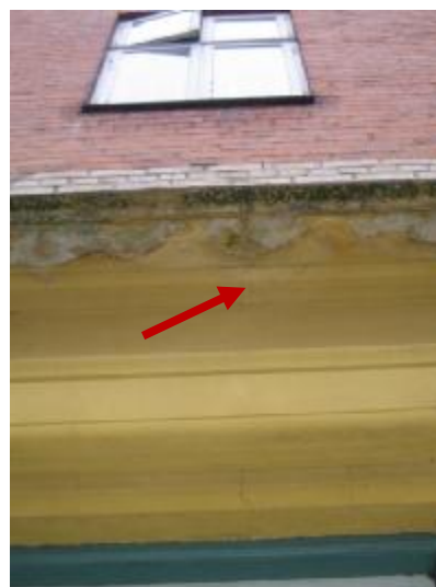
Revnedannelse i betonbaldakin over fordør.
