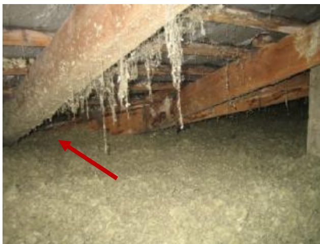
Isolering ført helt ud mod spærfod.
