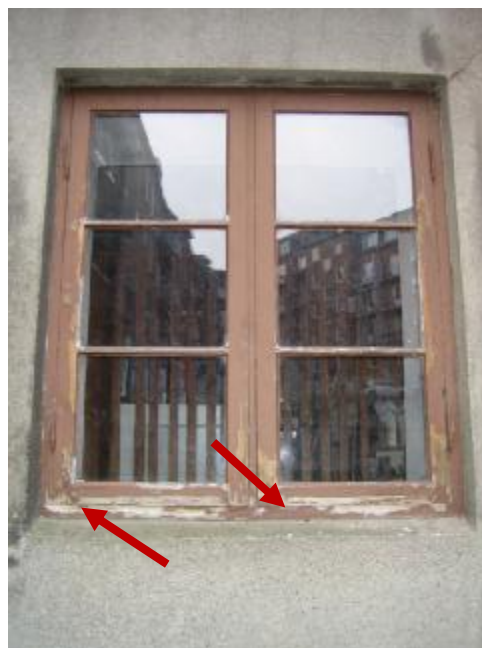
Kældervindue med kraftig malingsafskalling.
