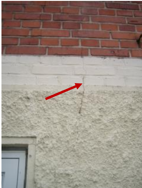
Sætningsrevne i sokkel mod Skovbrynet 2 som fortsætter op i murværk
