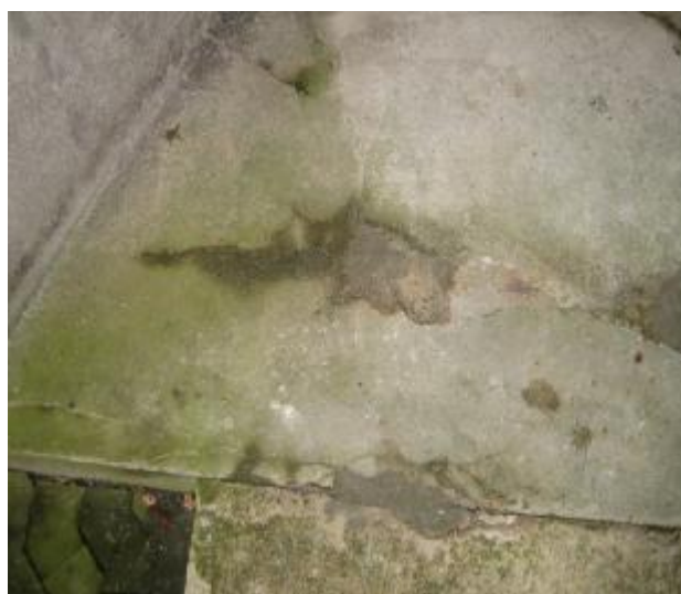
Revnet, afskallet og skruk gulv i port/ mellemgang.
