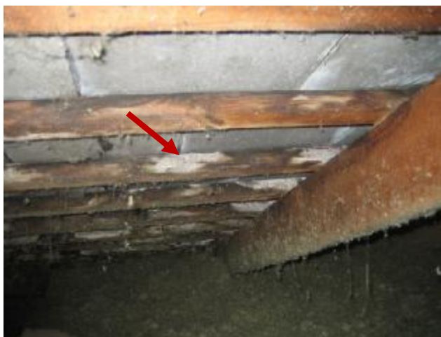
Fugtskjolder samt mug-/ skimmelvækst på spær, lægter og skiffertagplader i tagrum.
