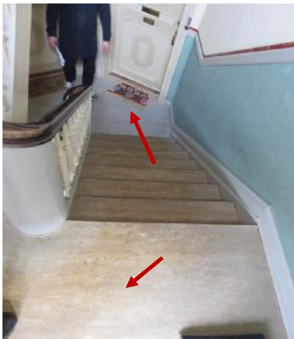
Henholdsvis ny og gl. vinylbelægning på hovedtrappe.
