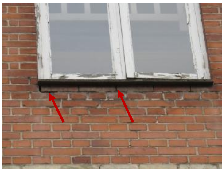
Udfaldne/ manglende fuger under sålbænke.
