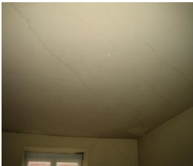
Revner i loft i trappeopgang.
