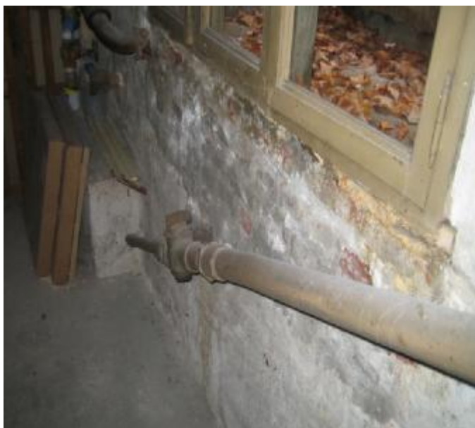
Fugtskadede kælderydervæg under lyskasse.
