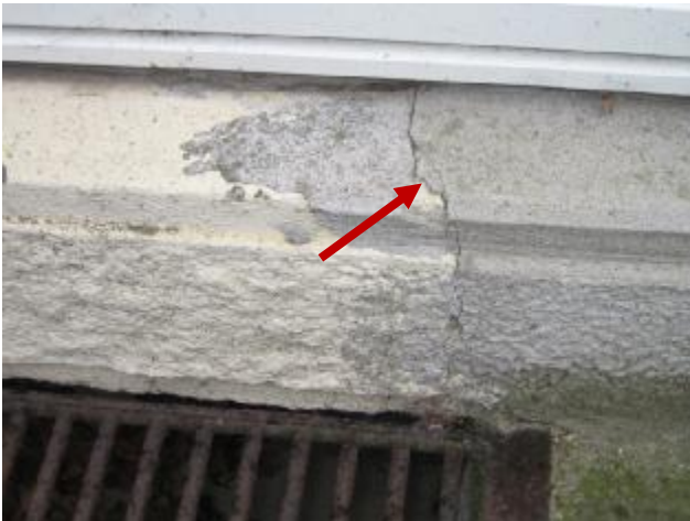
Revne og skruk puds på sokkel mod Prins Christians Gade 10
