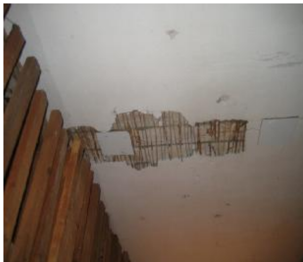
Revnet og afskallet loftspuds i kælderrum.
