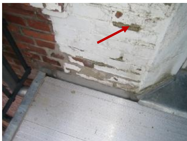
Revnedannelse i murværk samt afskallet maling/ puds.
