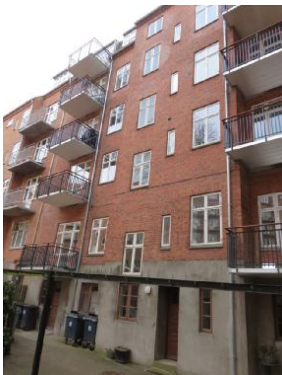
Facade til gårdside nr. 10
