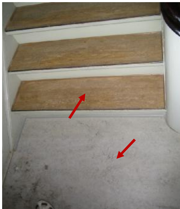
Henholdsvis ny og gl. vinylbelægning på hovedtrappe.
