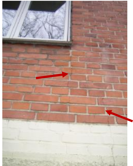
Sætningsrevne i sokkel mod Skovbrynet 2 som fortsætter op i murværk
