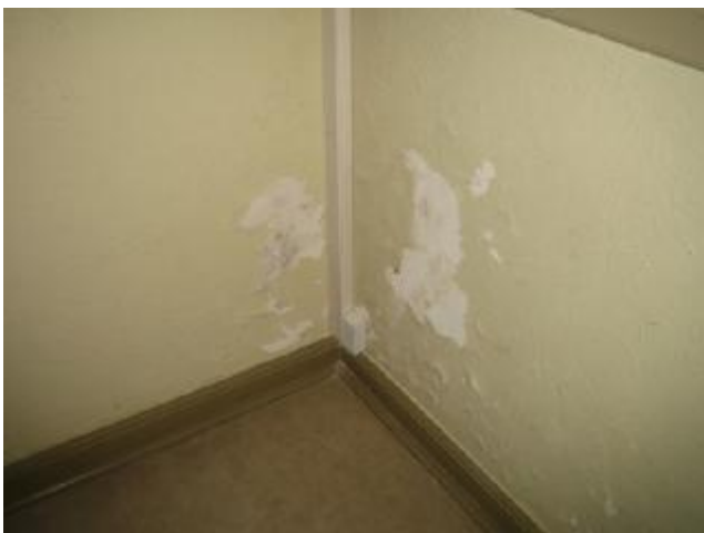
Afskallet strukturmaling på vægoverflader fortrappe nr. 2
