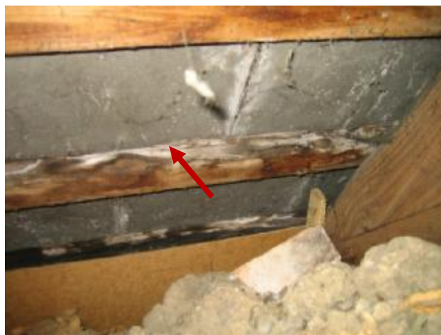
Fugtskjolder samt mug-/ skimmelvækst på lægter og skiffertagplader i tagrum.
