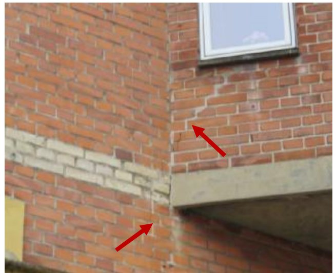
Revnedannelse i murværk mellem fordør og karnapvindue
