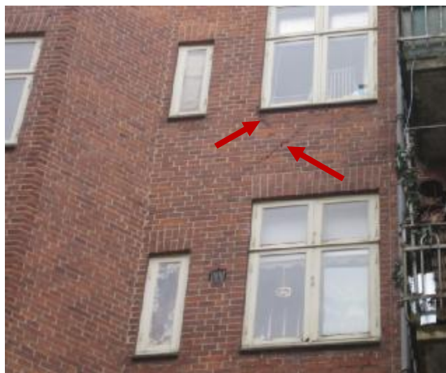
Revnedannelse i murværk under vindue mod gård.
