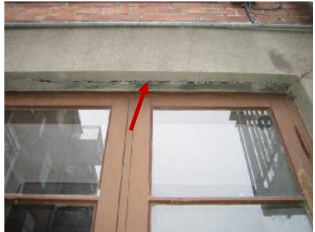
Revnet og skruk puds på underfacade mod gård.
