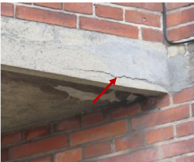
Revnedannelse i pudset kant under karnap.
