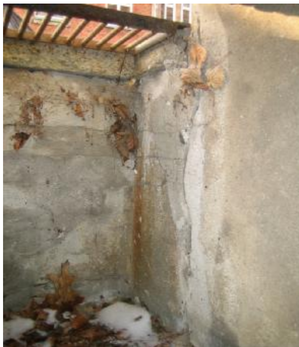
Lyskasse med kraftig revnedannelse set fra kælder.
