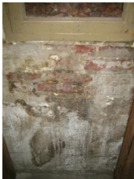
Fugtskadede kælderydervæg under lyskasse.
