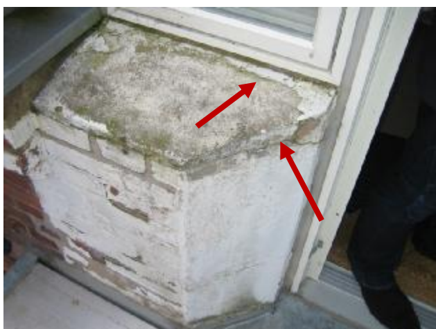
Revnedannelse i og under betonaafdækningen.
