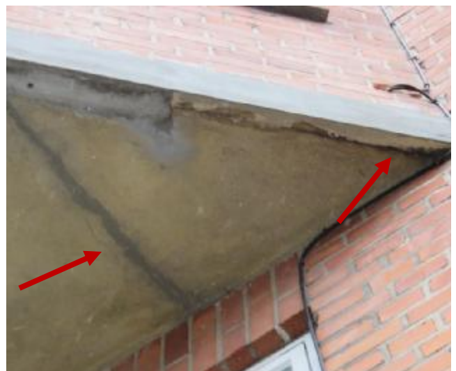
Revnedannelse i bunden af karnap samt rustudtræk.
