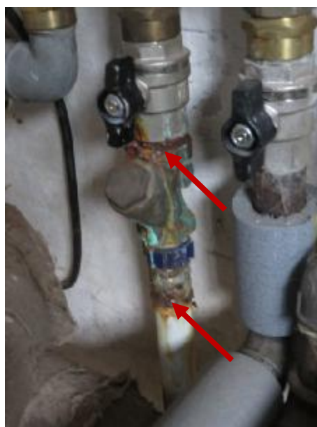
Rørsamlinger på varmeinstallation i fyrrum med tegn på sivning og begyndende tæring
