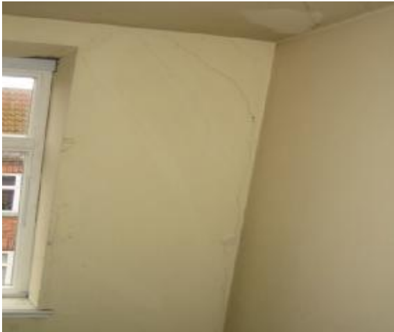
Revnedannelse i vægoverflader fortrappe nr. 10
