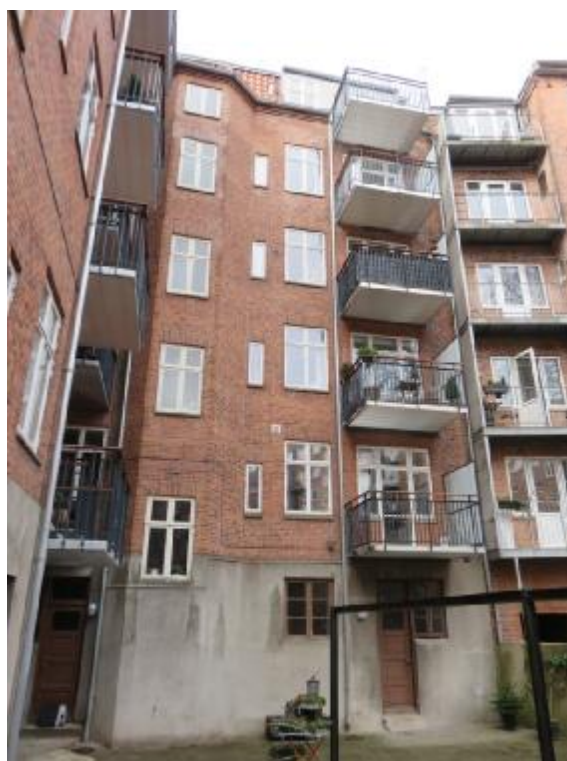
Facade til gårdside nr. 2
