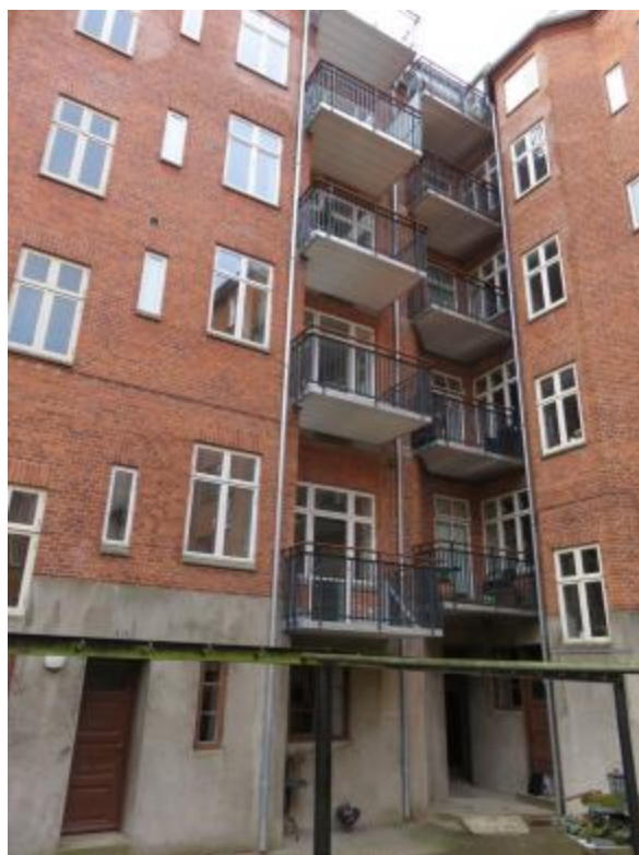
Fine nye altaner til gårdside.
