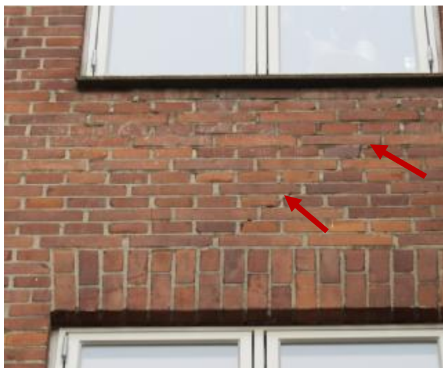
Revnedannelse i murværk under vindue mod gård.
