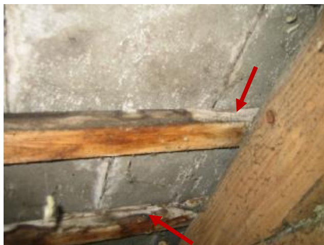
Fugtskjolder samt mug-/ skimmelvækst på lægter og skiffertagplader i tagrum.
