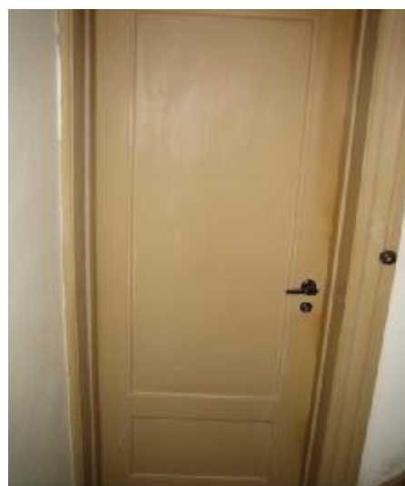
Lejlighedsdør til bitrappe.
