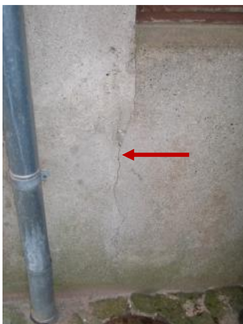
Revne og skruk puds på sokkel mod gård.
