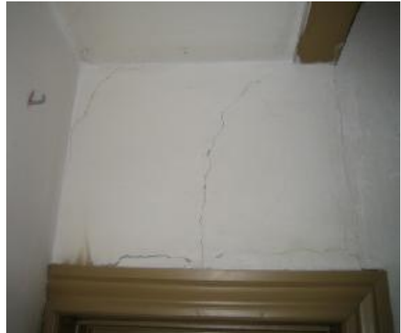
Revnedannelse i vægoverflader bagtrappe nr. 2
