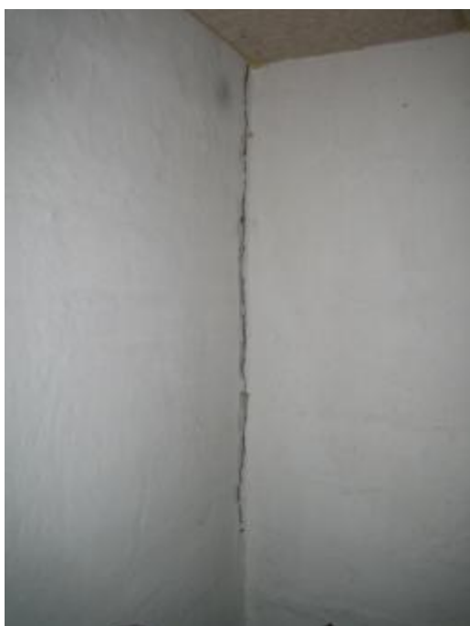
Sætningsrevne i nordøstlig hjørne i cykelkælder.
