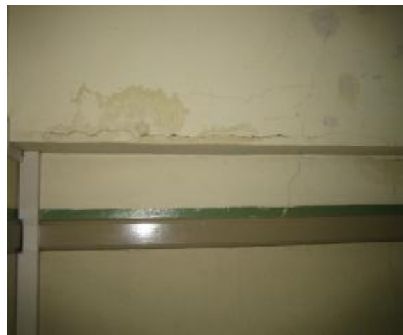
Revnedannelse i vægoverflade fortrappe nr. 2
