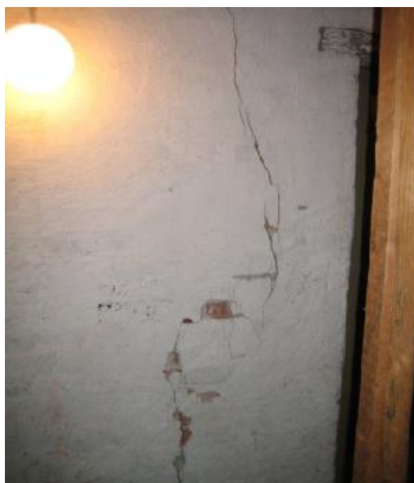
Revnedannelse og afskallet puds på kældervæg..
